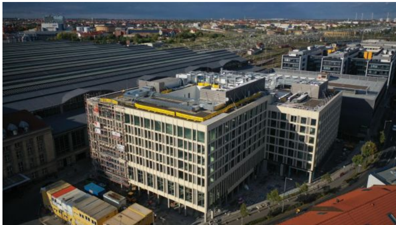
Gerüstfall beim Hotel-Großprojekt am Leipziger Hauptbahnhof (S&G Development GmbH/ Stephan Dietze).
