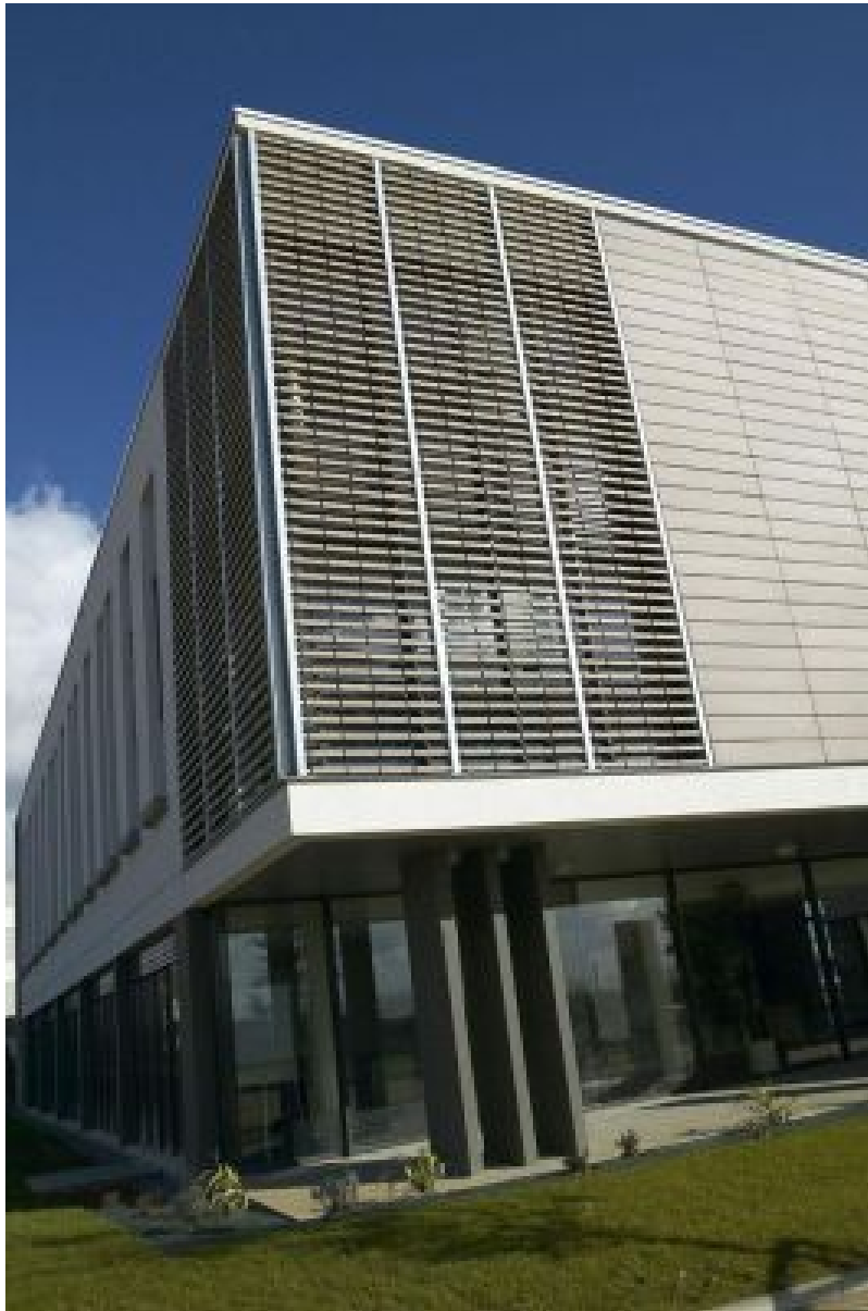
Zeitlos-harmonische Gestaltung von Fassaden aus Terrakotta von TERREAL
