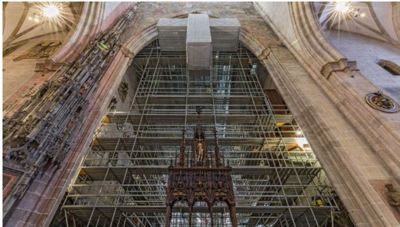
Das 13.000 m 3 große PERI UP Raumgerüst im Chorraum des Ulmer Münsters wurde freistehend ausgeführt.
