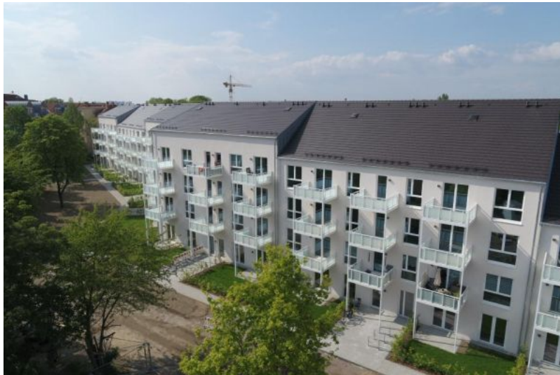
VONOVIA baut in ALHO Modulbauweise
