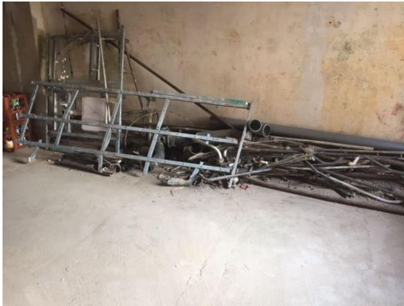
Asbestbodensanierung und Industriedemontage
