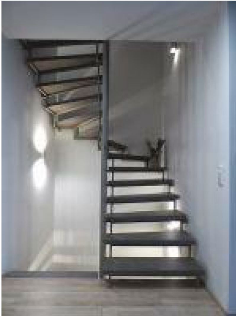
Neue Treppe mit Blockstufen
