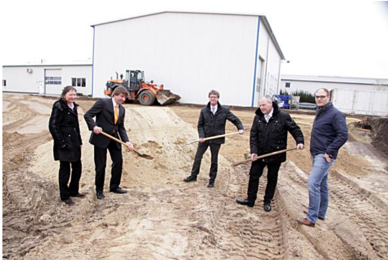
In Wardenburg errichtet die HIT Hafen- und Industrietechnik eine neue Produktionshalle.
