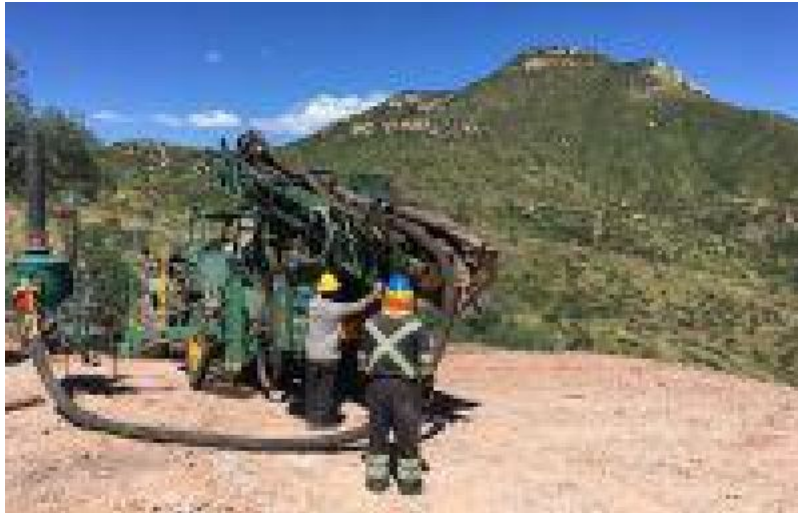
Bohrgerät auf Cerro Caliche; Foto: Sonoro Metals
