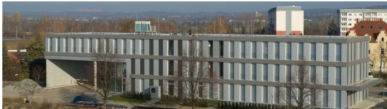
ProContain Büro-Neubau in Coswig
