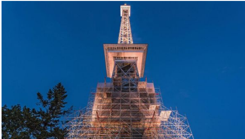
Der Berliner Funkturm wurde 2018 bis zur Restaurantkanzel in knapp 50 m Höhe aufwändig saniert.
