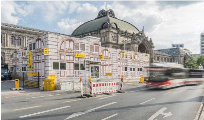
Optisch wurde die Gebäudehülle an die Fassade des Bahnhofs angepasst
