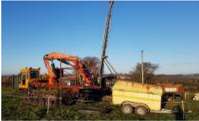
Bohrung auf einem Zinkprojekt in Irland; Foto: Group Eleven Resources
