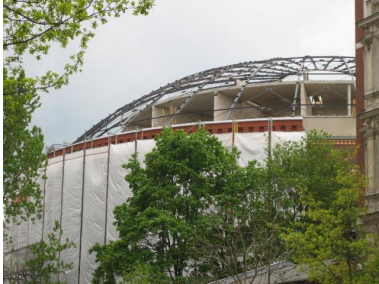
Baustelle Fichtebunker mit merkwürdigen rechteckigen Öffnungen aufs Flachdach.
