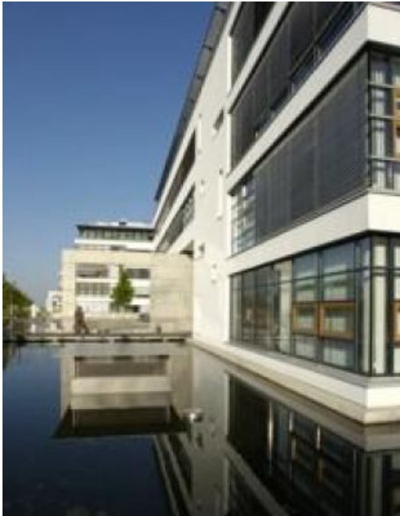
Die IZB-Zentrale in Aschheim. Foto: IZB Informatik-Zentrum; Andreas Huber, Berg
